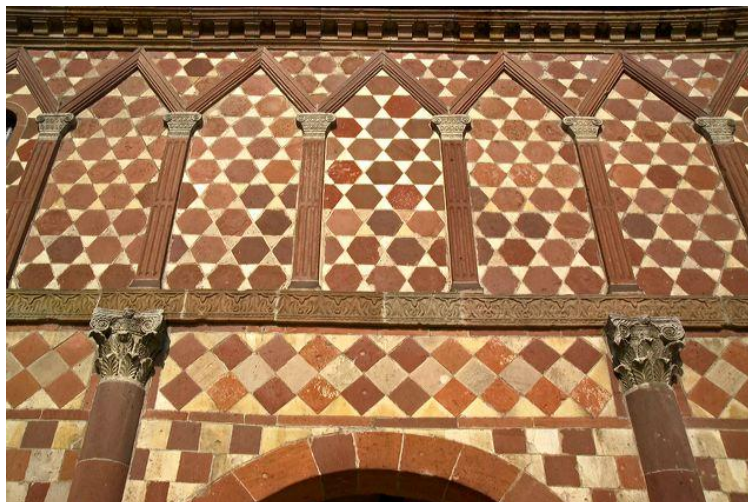
La porte triomphale de l'abbaye de Lorsch (détail) : les « arcs mitrés »
